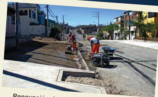
Renovación de calzada, construcción de vereda, berma, sardinel en la calle 8 de Octubre.
