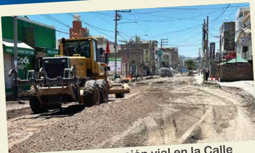
Drenaje y renovación vial en la Calle Colón, importante vía de alto tránsito del distrito.
